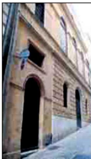
L'ingresso della sinagoga
